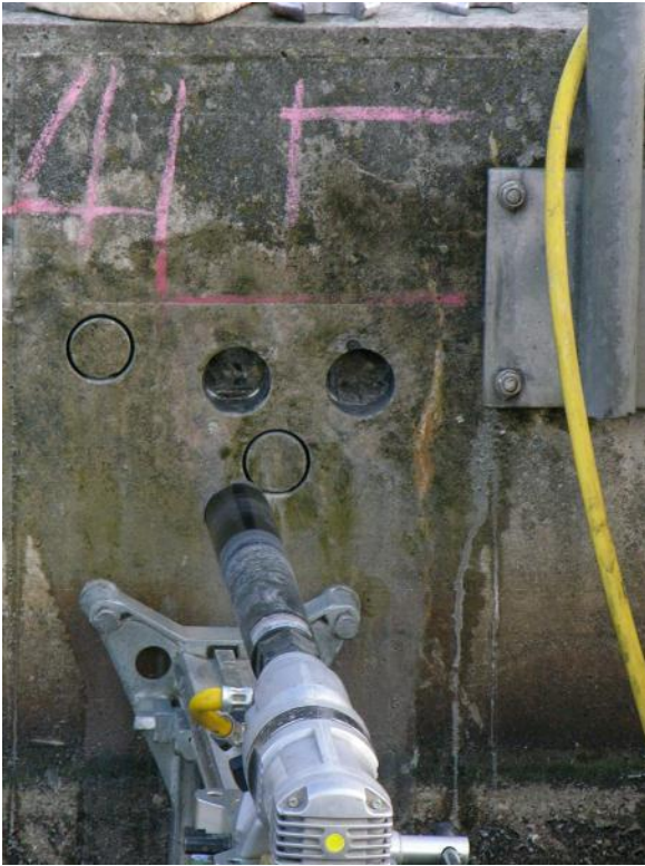
Bild 3: Bauzustandsuntersuchung im Belebungsbecken
