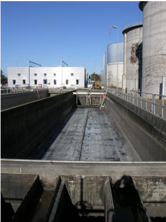
Bild 4: Bauzustandsuntersuchungen im Vorklärbecken
